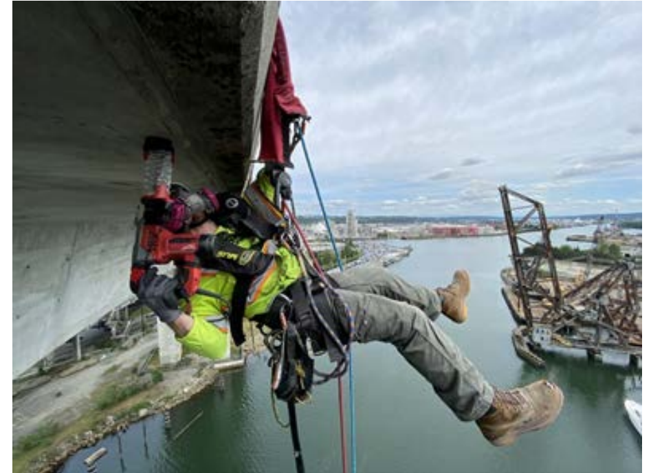
고가 다리의 초기 안정화는 2020년 말에 Kraemer North America에 의해 완료되었으며 2단계(재건) 작업도 이룰 것입니다.
