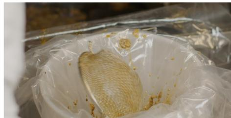
**3** 将所有积聚的油脂从隔油器中清除并置于防水容器中。
