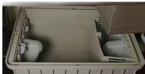
**6** 更换挡板，然后用盖子密封隔油器。
