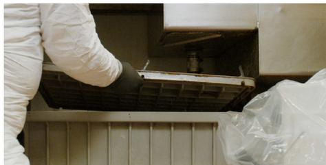
**1** 取下隔油器的盖子，将油脂分离器或隔油器中的水排出。
