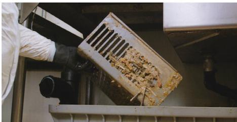
**2** 如有可能，拆除隔油器内的壁板。这些壁板被称为挡板。
